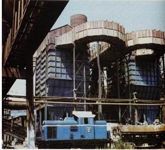
Electrofiltre, Aglomeratorul II
